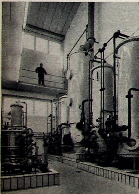
Wasseraufbereitungsanlage für die Deionisierung und Vollentsalzung
